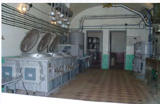
Küche in der Bunkeranlage Schoeneburg
